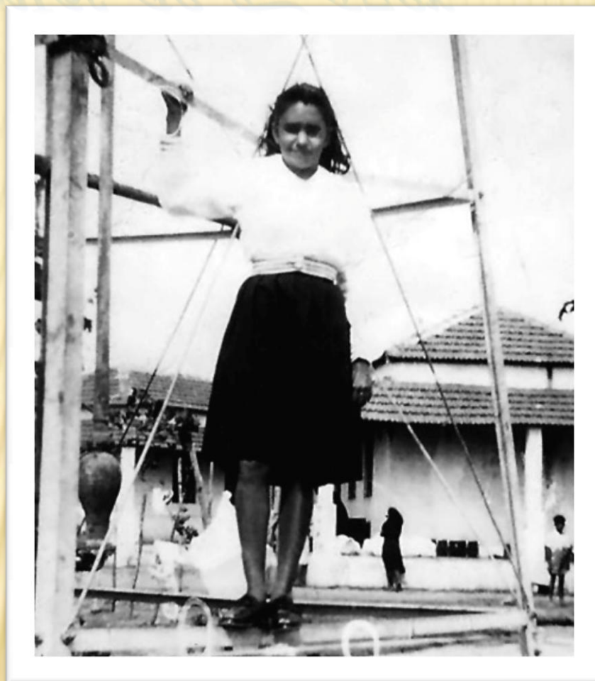
Aluna da Escola em cima do antigo catavento
